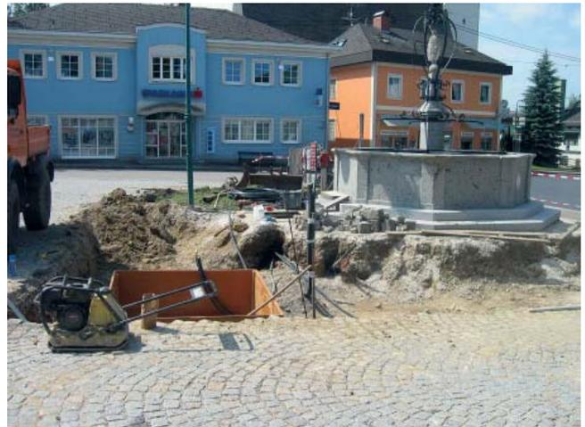
*Der Holzkasten vorne links dient dazu, dass sich Schotter und Erde für die Bäume nicht vermischen. Er wird nach dem Befüllen herausgezogen.*
