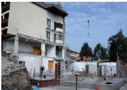
Foto: Altenheim - Baustelle im Oktober.
