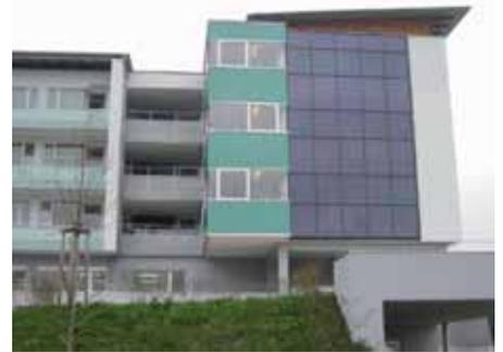
Mit 130 m<sup>2</sup> Fassadenkollektoren werden jährlich 46.000 kWh erzeugt. (=4.600 Liter Öl).
