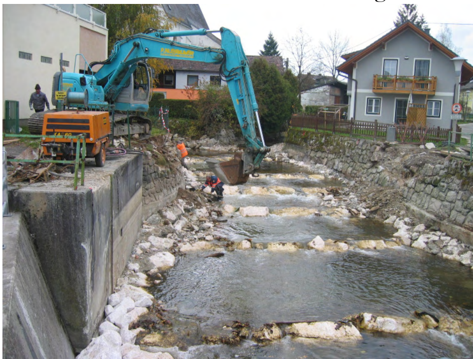
Platzl: Das Frickh-Wehr wurde abgerissen und durch Steinschwellen ersetzt.
