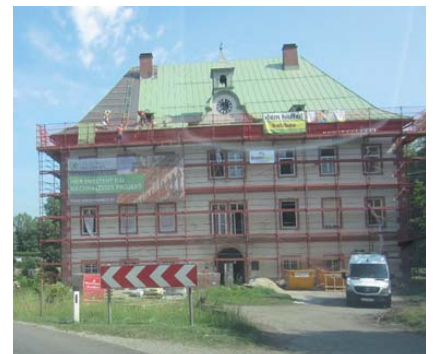
Die Umbauarbeiten im Schloss Frein durch die Green Finance GmbH gehen weiter. Bild © Marktgemeinde
